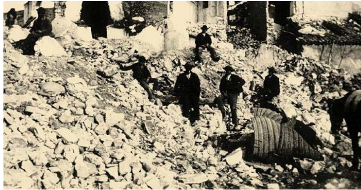
Terremoto 1884 Arenas del Rey
