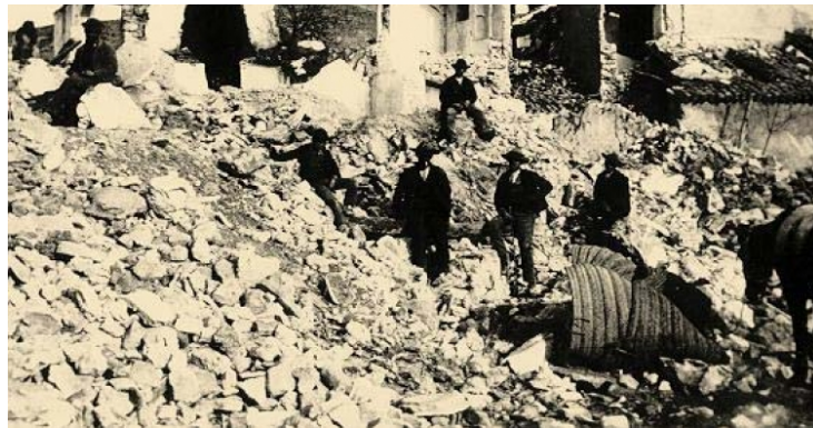
Terremoto 1884 Arenas del Rey
