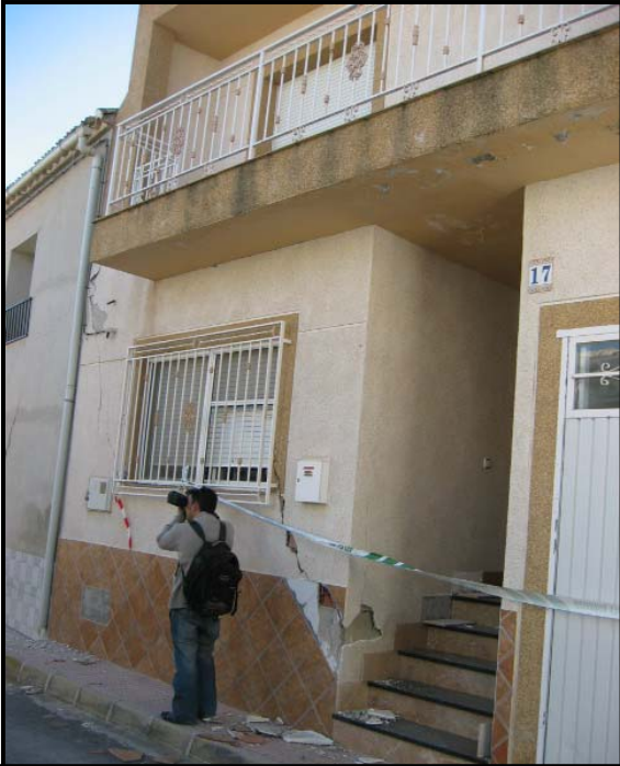
Ejemplos de daños en estructuras de muros de carga de fábrica de ladrillo y forjados de Hormigón armado en Zarcilla de Ramos
