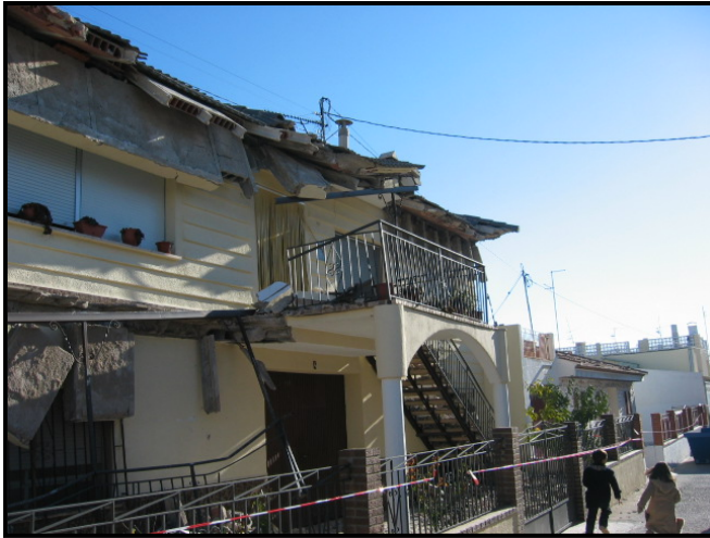
Ejemplos de daños en estructuras de muros de carga de fábrica de ladrillo y forjados de Hormigón armado en Zarcilla de Ramos
