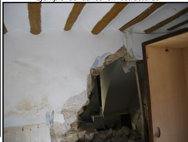
Ejemplo de daños en estructuras
