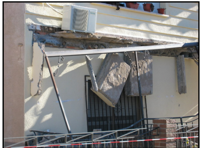
Ejemplos de daños en estructuras de muros de carga de fábrica de ladrillo y forjados de Hormigón armado en Zarcilla de Ramos
