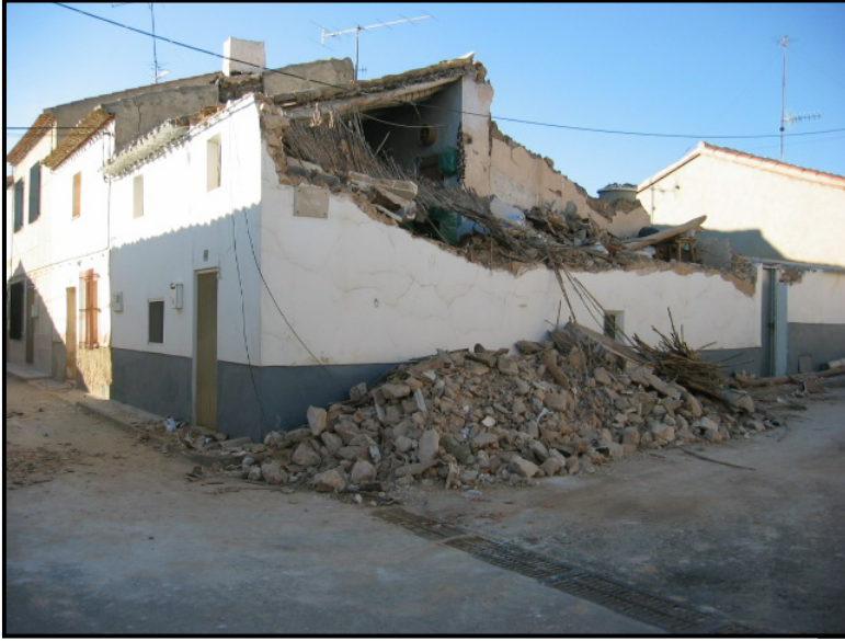
de muros de carga de piedra y barro en Zarcilla de Ramos
