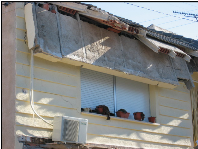
Ejemplos de daños en estructuras de muros de carga de fábrica de ladrillo y forjados de Hormigón armado en Zarcilla de Ramos
