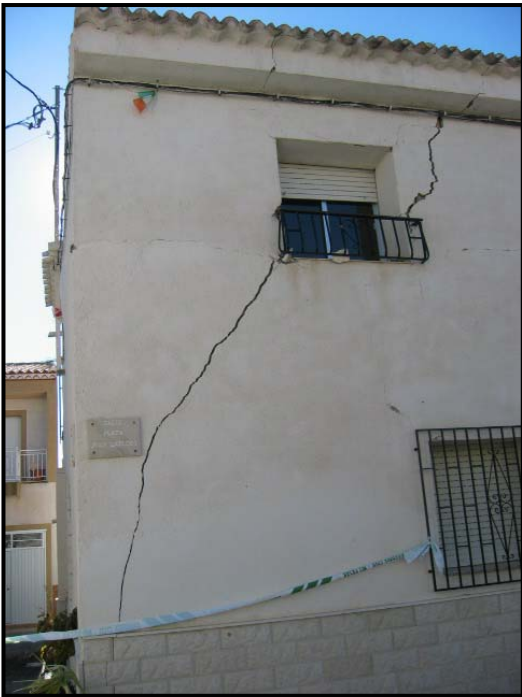
Ejemplos de daños en estructuras de muros de carga de fábrica de ladrillo y forjados de Hormigón armado en Zarcilla de Ramos
