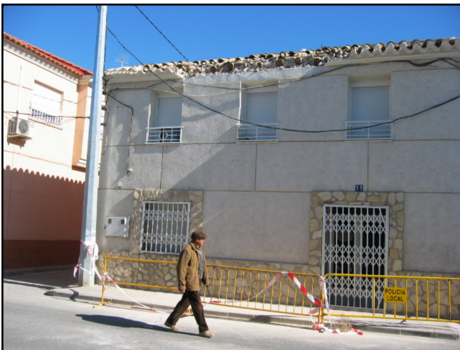
Ejemplo de daños en estructuras de muros de carga de fábrica de ladrillo y forjados de Hormigón armado en La Paca
